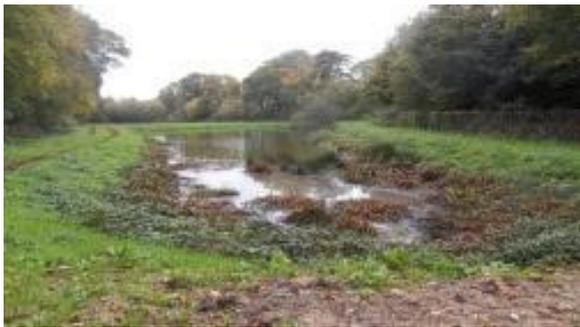
Opérationnelle depuis sa création en 1997, la station d'épuration ou (lagunes) fonctionne par système gravitaire. 100 branchements y sont raccordés, exclusivement dans le bourg.
