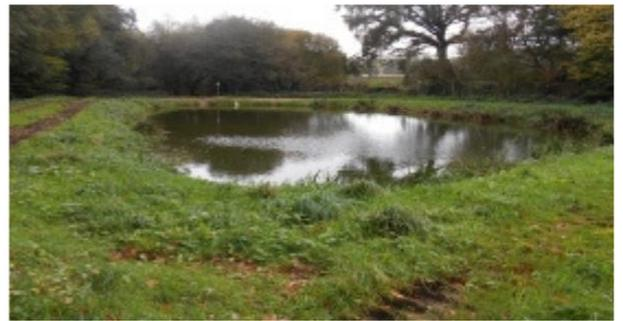
A l'entrée se trouve un dégrilleur qui retient les plus grosses particules, ensuite les eaux usées passent par 3 bassins de filtration, et pour finir l'eau filtrée est rejetée dans le petit ruisseau en contre-bas. De plus, des analyses de conformité sont effectuées tout au long de l'année.
